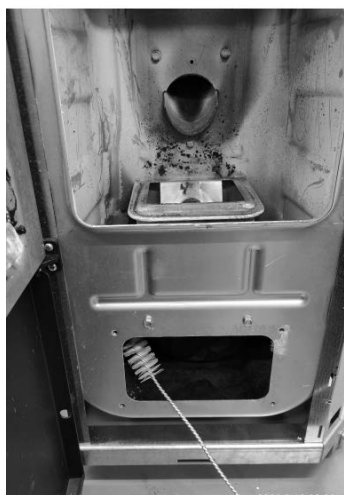
Fig. 31 - Mit einer Rohrreinigungsbürste reinigen
